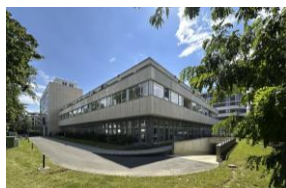
GAP Gästehaus am Park, Leipzig
